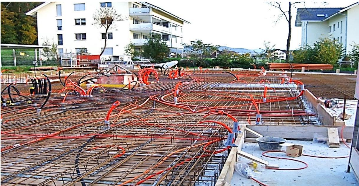
**Eingelegte Elektrorohre vor dem Betonieren <sup>2</sup>**
