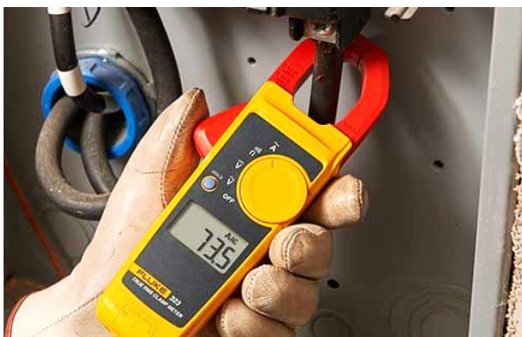
Abb. 70: Strommessung mit Stromzange
